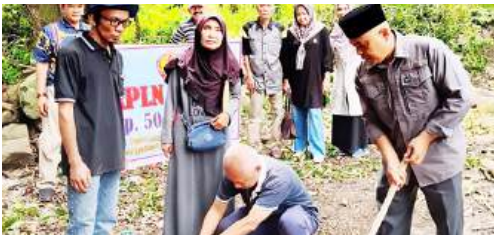
Peletakan batu pertama Pembangunan rumah Ibu Elismaniar janda pensiunan PLN di Daerah Malako Kab Tanah Datar yang hancur dan hilang terbawa banjir, dilakukan oleh Ketua IKPLN Daerah Sumbar Bpk Mardanis.
