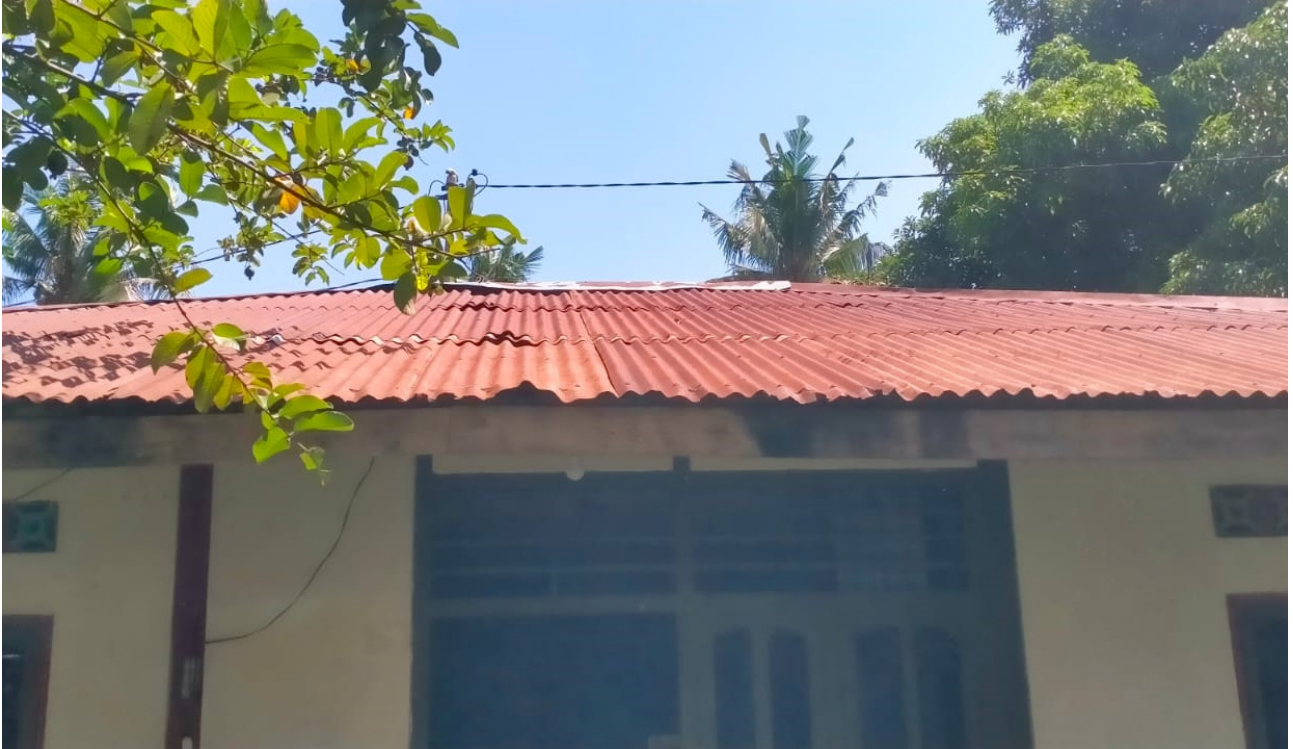
Rumah Pensiunan IKPLN Cabang Sumba, Papu Dima sebelum perbaikan.
